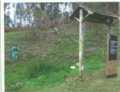
Actuaciones ejecutadas en Colindres.
